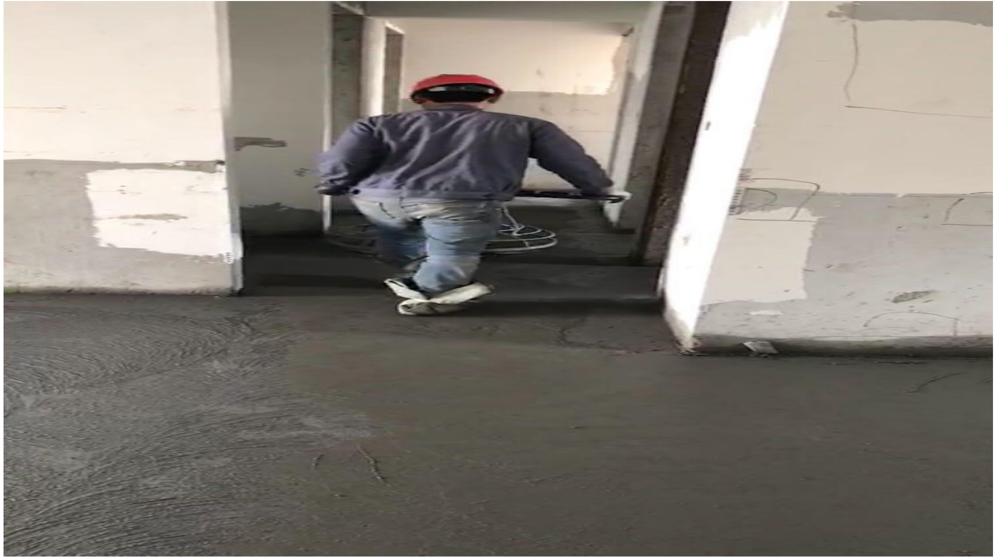
图8 磨光机打磨
