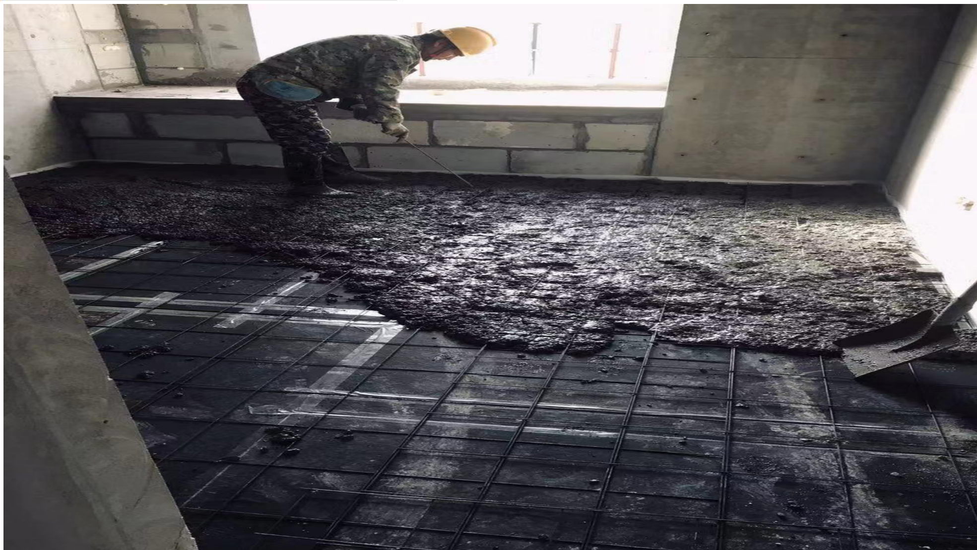
图7 浇筑混凝土、提拉钢丝网片
