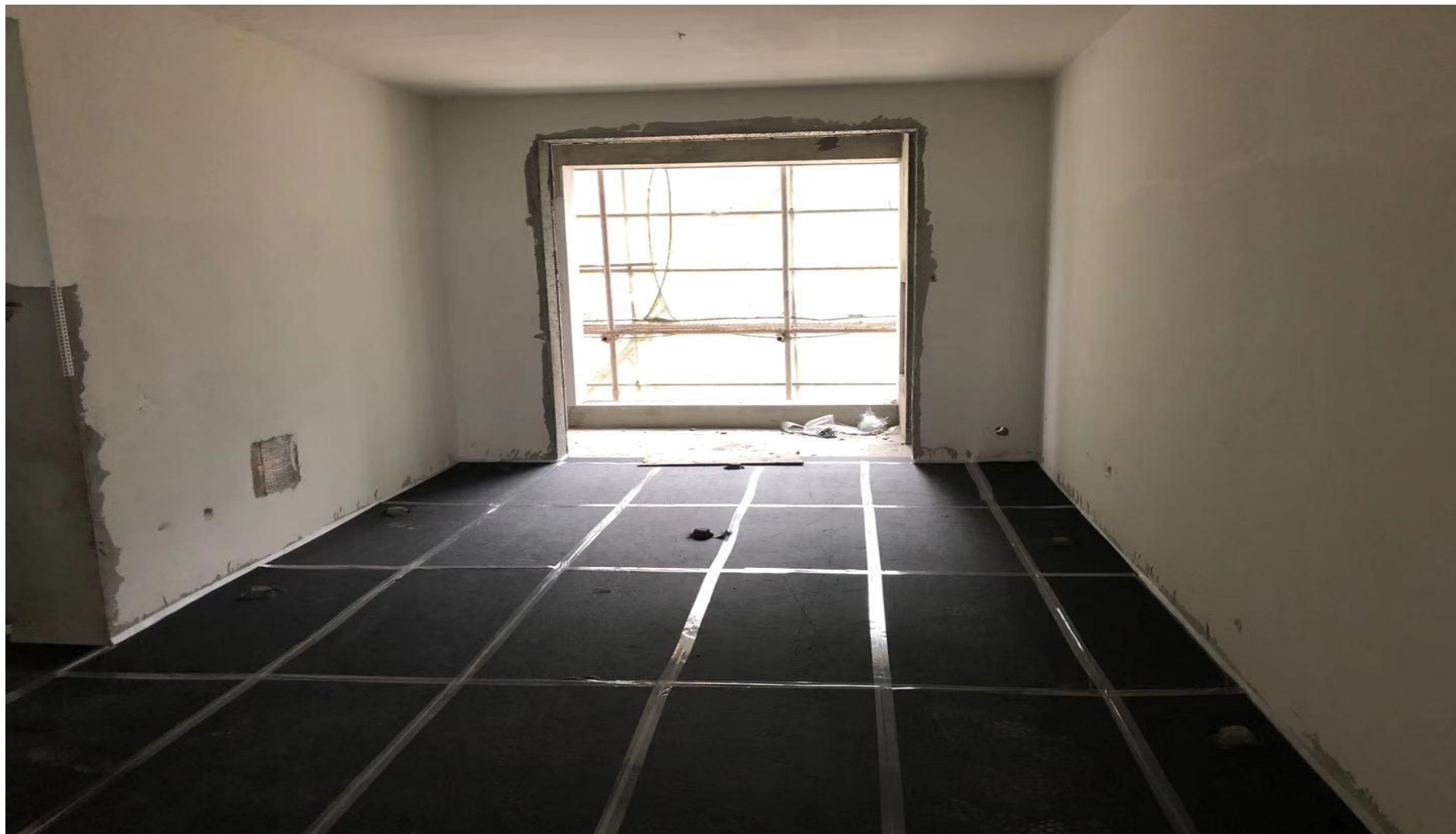
图4 铺设保温板，粘贴防水胶带
